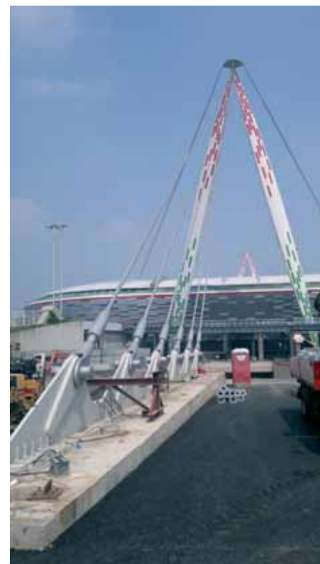
Fig. 4 - Ancoraggi degli stralli alla fondazione
